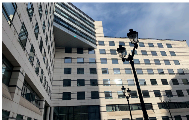
Immeuble Diamant - entrée A
